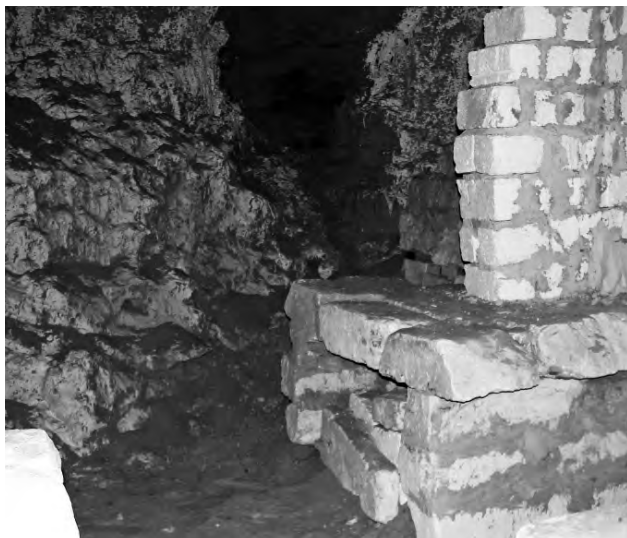
Consolidació i sosteniment de la volta de la galeria 2.
